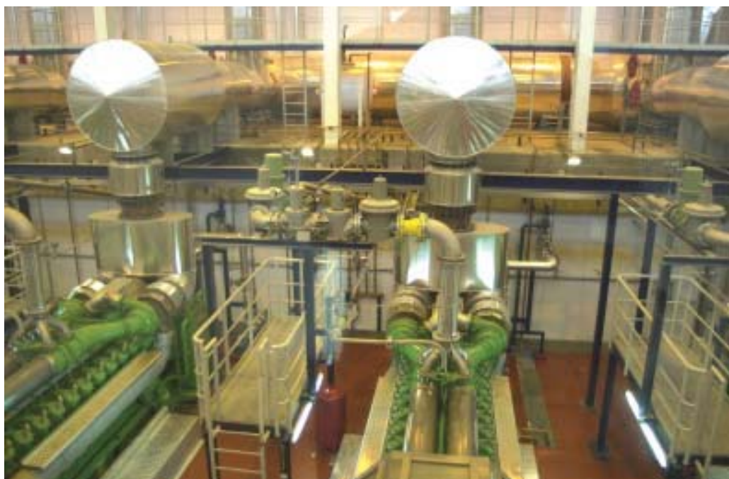
Se han instalado 10 estaciones de regulación y medida automática.
